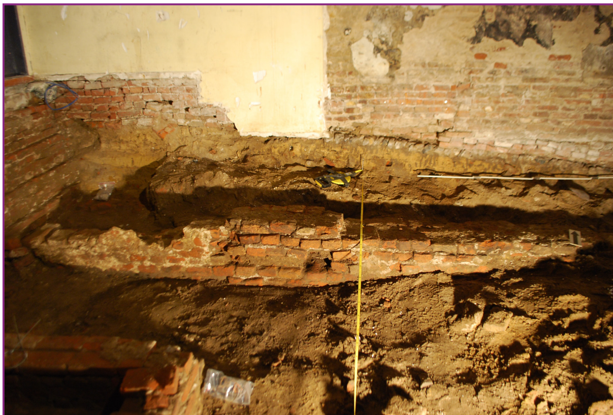
Afbeelding 12. Aanzicht in richting van het oosten van de funderingsvoet (spoor 17) (met links delen van bepleistering of een bouw- of reparatiefase) en een restant van opgaand muurwerk (spoor 18).
