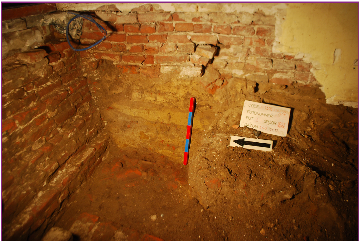
Afbeelding 10. Spoor 19, vloer of funderingsrestant van baksteen en dakpanfragmenten in de noordoosthoek van de werkput.
