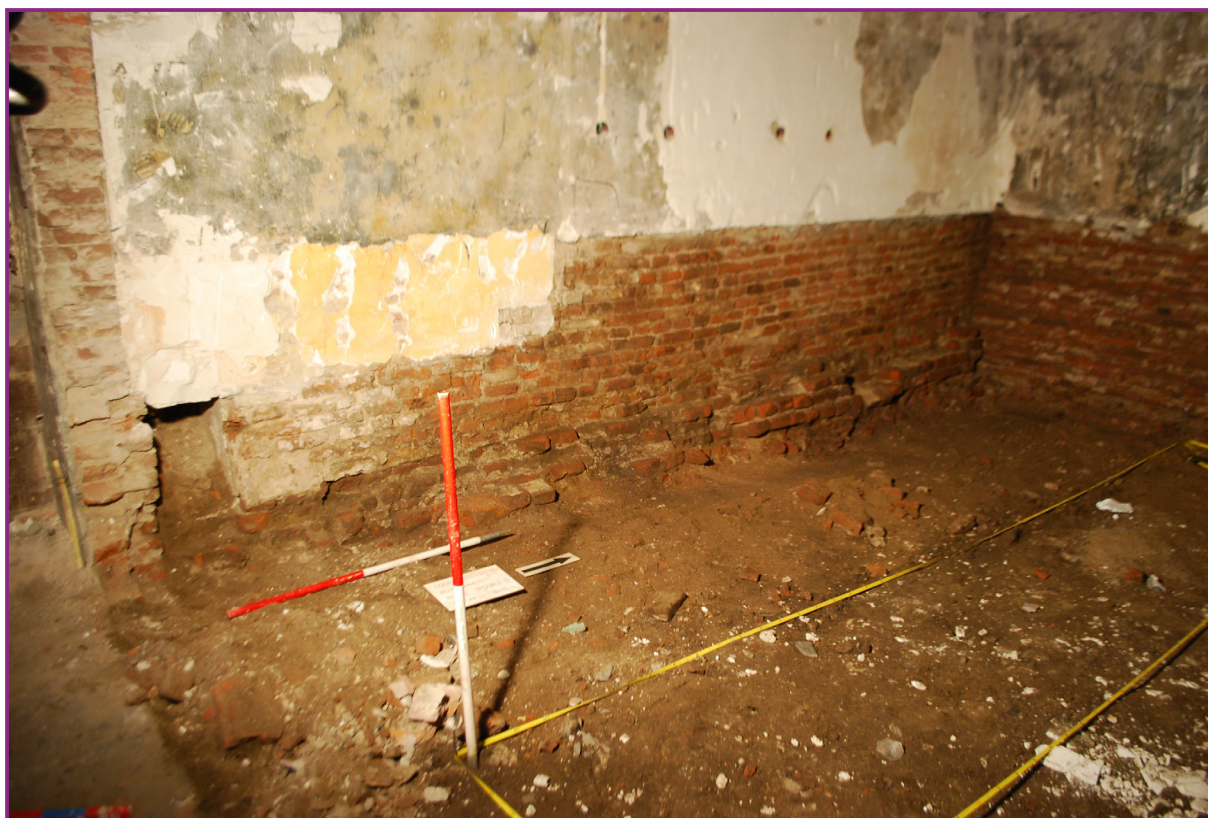
Afbeelding 11. Westgevel op rommelige vertandingen van de funderingsvoet die schuin naar het noordoosten uitloopt.
